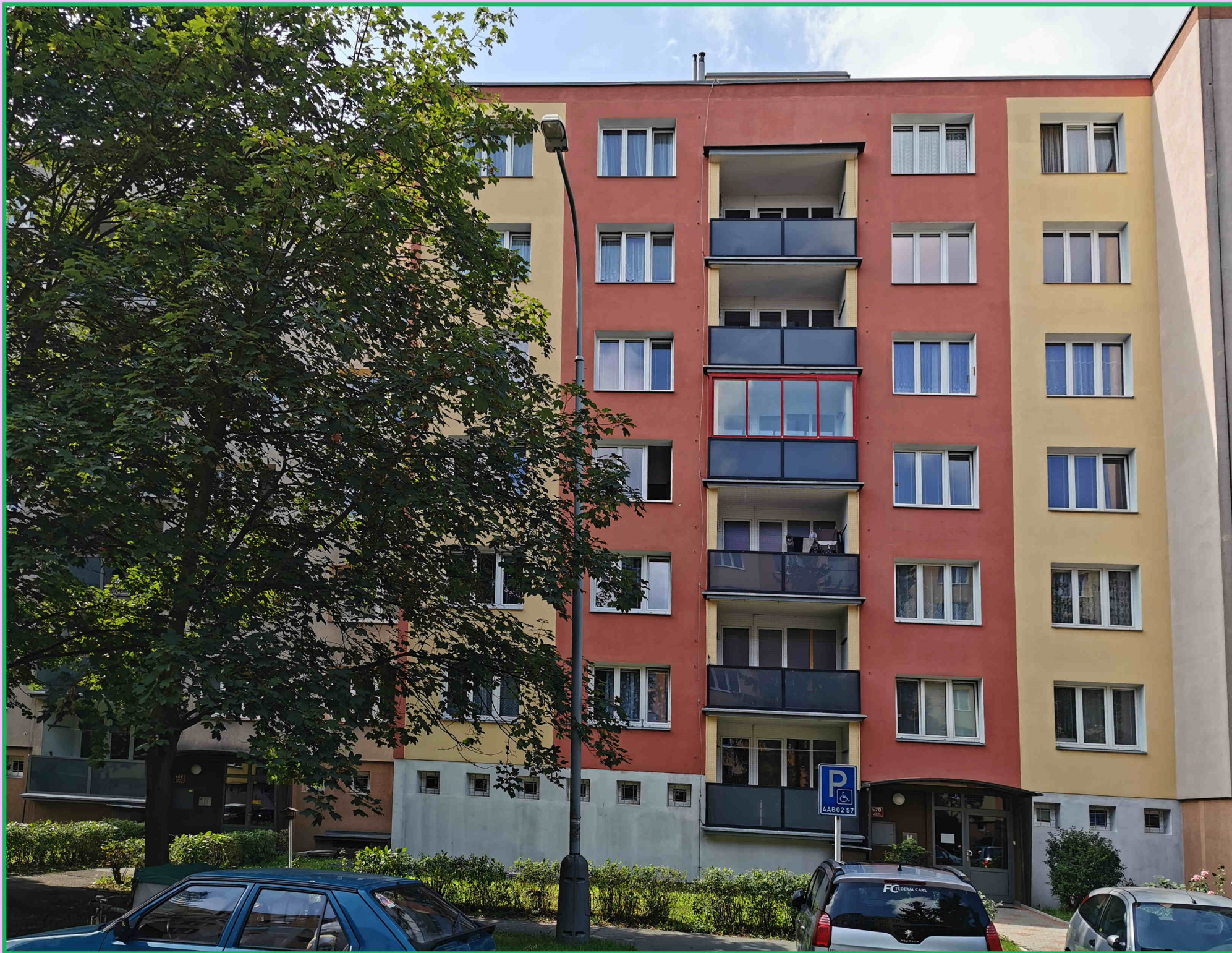
Dům v rekonstrukci-přední fasáda 22.08.2019
