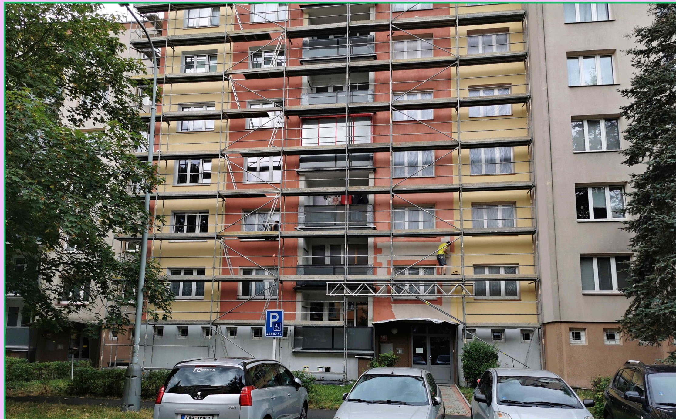
Dům v rekonstrukci-přední fasáda 10.08.2019
